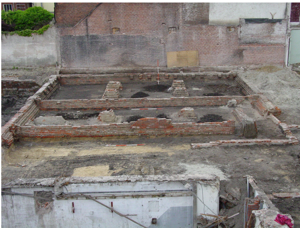
Afb. 4.16. De fundamenteen van het oudste deel van het Tehuis uit 1898; foto genomen in zuidelijke richting.
